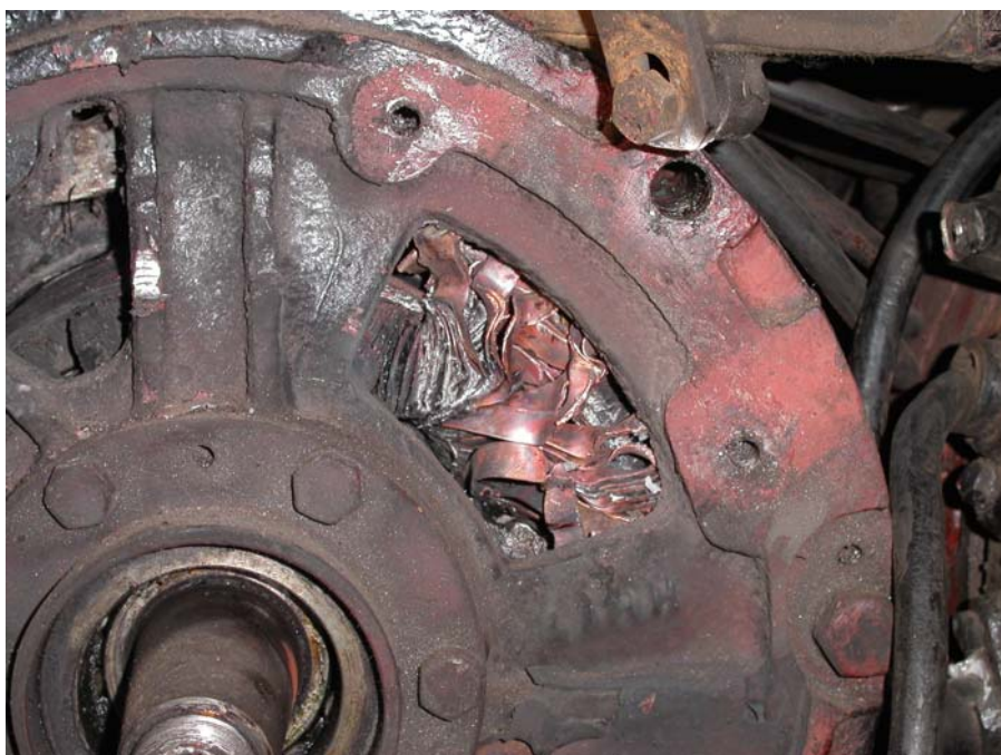
Il. 5. Spalone uzwojenia silnika trakcyjnego
