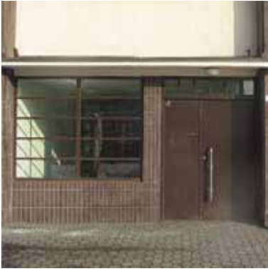
Fot. 36. Wejście do I klatki schodowej (fot. A. Marczevska 2013)
