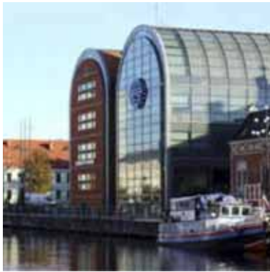
Fig. 1. Bre Bank in Bydgoszcz (phot. K. Strumiłło)
