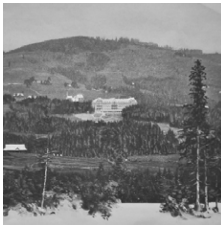
Fot. 7. Elewacja południowa, 1902 r.
