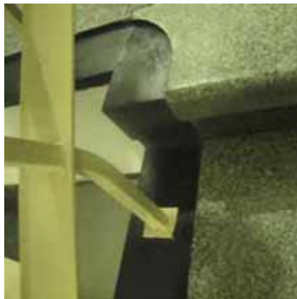
Fot. 32. Detal poręczy schodów (fot. A. Marczevska 2013)
