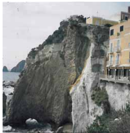
Fot. 18. Via Parata – Uliczka Zapora. Widać stare grotty. Na górze pozostałości wili z czasów rzymskich (fot. T. Leszczyński)
