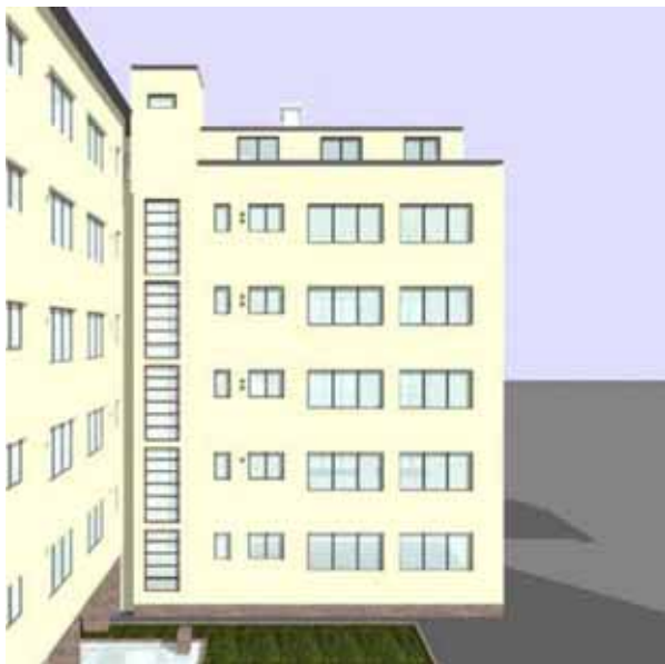
Ryc. 8. Przeszklenie szybu windowego – rekonstrukcja (rys. A. Marczevska)
