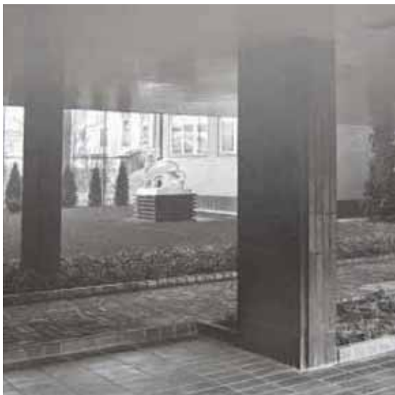
Fot. 9. Widok z podcieni na zielone podwórze (fot. Cz. Olszewski 1936)
