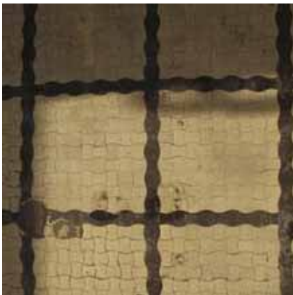
Fot. 31. Posadzka w sklepie. Dawniej również w holach klatek schodowych (fot. A. Marczevska)
