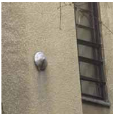
Fot. 28. Wylot wentylacji poziomej (fot. A. Marczevska 2013)
