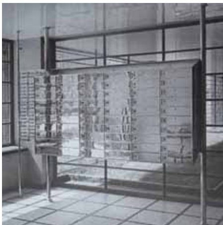
Fot. 34. Chromowana szafa na listy (fot. Cz. Olszewski 1936)
