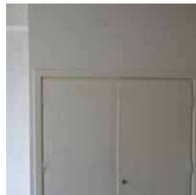
Fot. 27. Szafa maskująca podciąg (fot. T. Zalewski)
