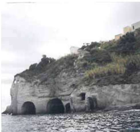
Fot. 9. Grotte di Pilato – Grota Piłata. Wewnątrz wydrążony w skale skomplikowany zespół basenów do hodowli ryb. Murenaio. Dawniej połączony z położoną powyżej willą Augusta (fot. T. Leszczyński)
