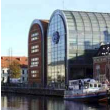
Fot. 1. Bre Bank, Bydgoszcz (fot. K. Strumiłło)
