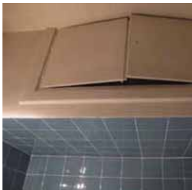
Fot. 22. Pokryty płytkami sufit pod pawlaczem w łazience (fot. A. Marczevska 2013)
