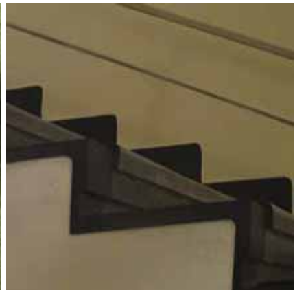
Fot. 33. Przestrzenne obrzeża stopni klatek schodowych (fot. A. Marczevska 2013)
