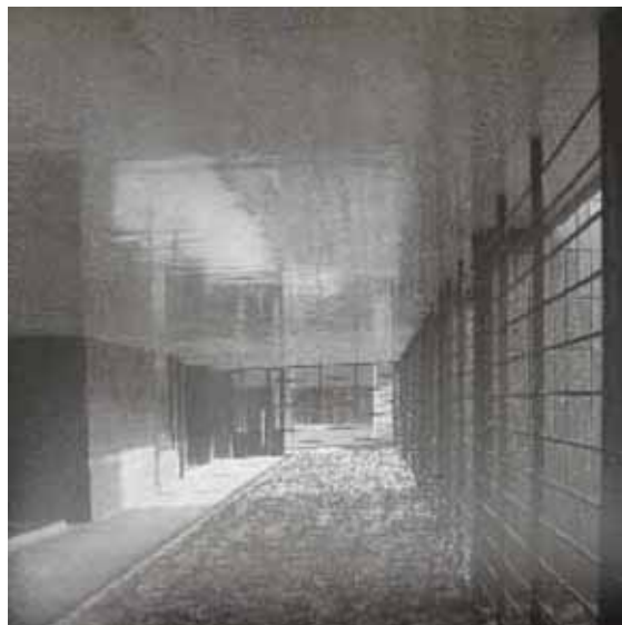
Fot. 10. Przejście łączące klatki schodowe (fot. Cz. Olszewski 1936)
