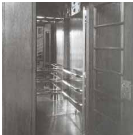
Fot. 35. Wnętrze kabiny windy (fot. Cz. Olszewski 1936)
