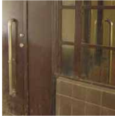
Fot. 37. Zachowane pochwytty przy współczesnych drzwiach (fot. A. Marczevska 2013)
