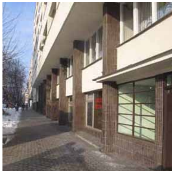
Fot. 12. Chodnik pod oknami budynku od strony ul. Madalińskiego (fot. A. Marczevska 2013)
