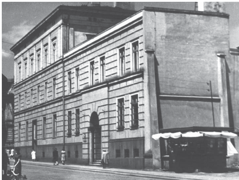
Rys. 7. Obiekt przewidziany do nadbudowy w widoku od strony południowej
