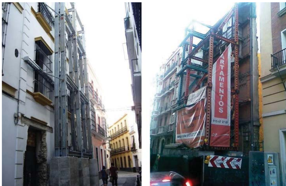
Rys. 3. Modernizacje w Sewilli z zachowaniem elewacji (fot. autor)
