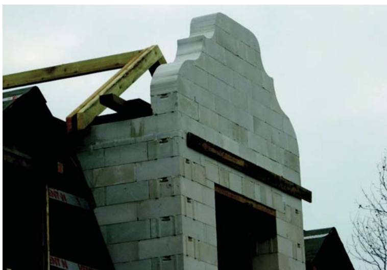
Fot. 6. Jednorodna ściana z ABK z precyzyjnie przyciętymi elementami
