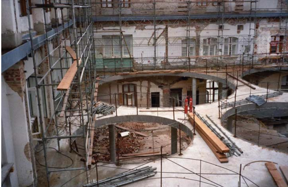
Rys. 13. Usztywnienie ścian fasadowych podłużnicami i żelbetowym stropem (fot. autor)
