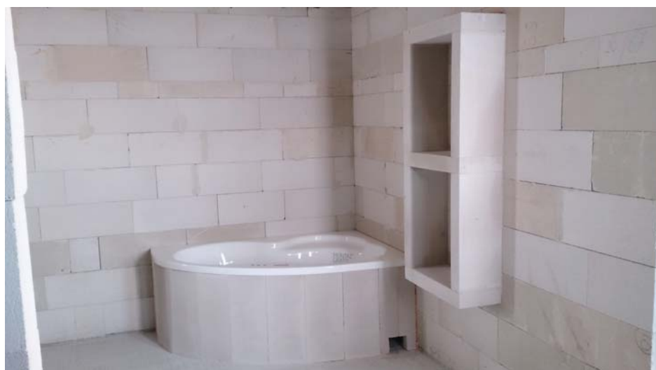
Fot. 4. Efekt połączenia betonu komórkowego na klej poliuretanowy
