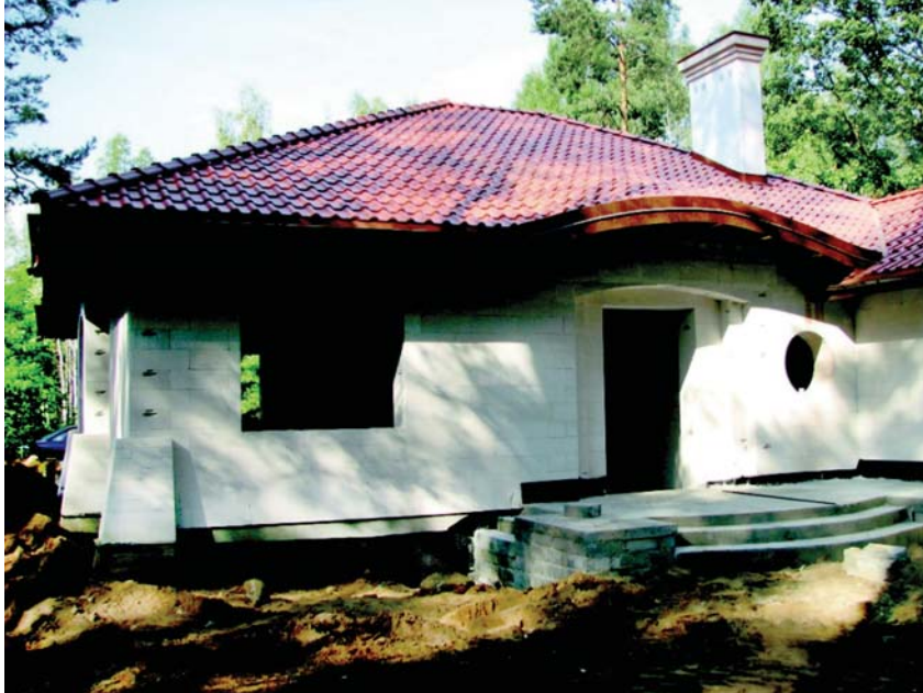
Fot. 7. Budynek jednorodzinny w systemie z ABK
