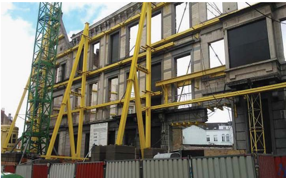
Rys. 2. Realizacja modernizacji budynku w Brukseli z zachowaniem elewacji (fot. autor)
