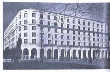
GMACH PRZY UL. KRAKOWSKIE PRZEDMIEŚCIE RÓG UL. TROLEWICKIEJ
