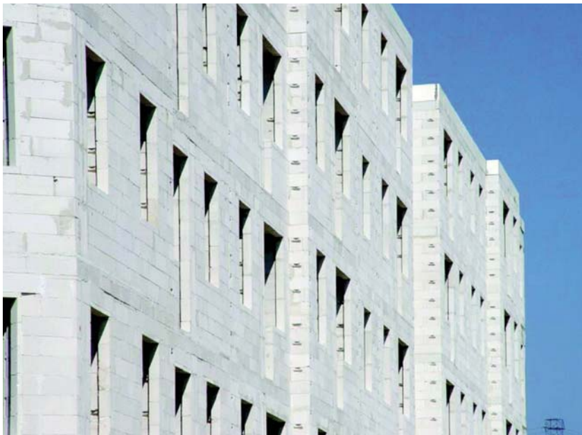
Fot. 8. Budynek wielorodzinny ze ścianami nośnymi zewnętrznymi w systemie z ABK
