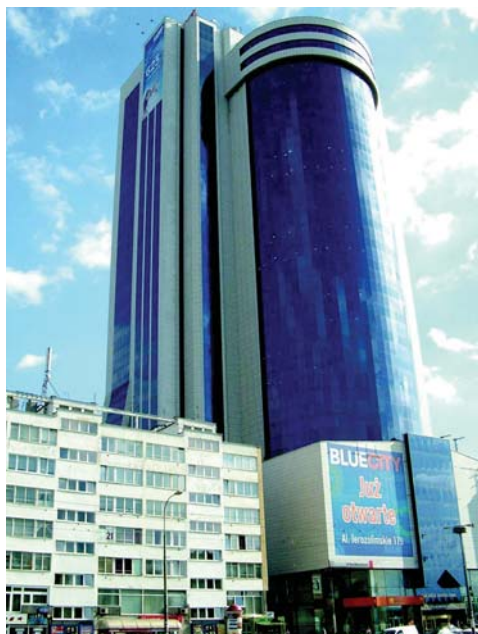
Fot. 10. Kontrowersyjny budynek przypominający kabinę prysznicową jest przykładem zastosowania ABK w budynkach wysokich [8]
