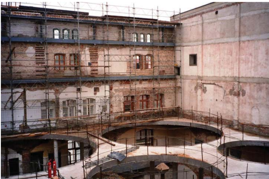
Rys. 12. Usztywnienie ściany południowej podłużnicami i żelbetowym stropem (fot. autor)
