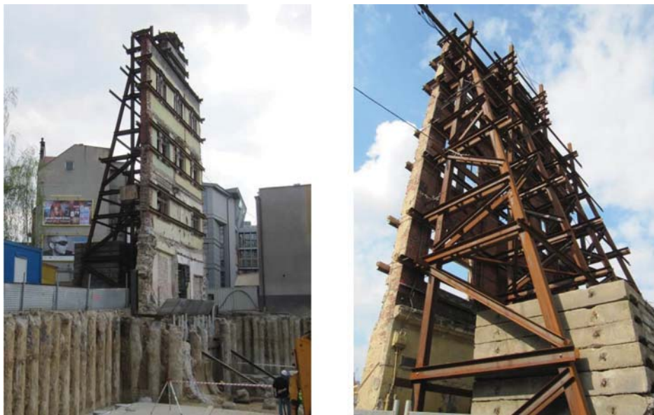
Rys. 7. Tymczasowa konstrukcja utrzymania ściany frontowej (fot. autor)
