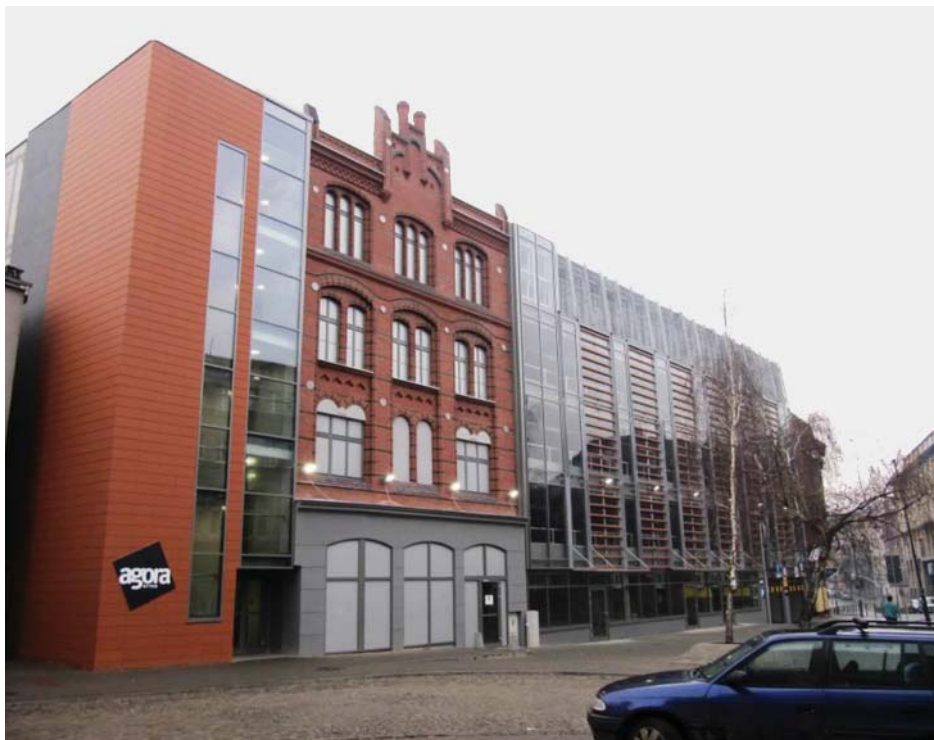
Rys. 8. Widok elewacji po zakończeniu inwestycji (fot. autor)
