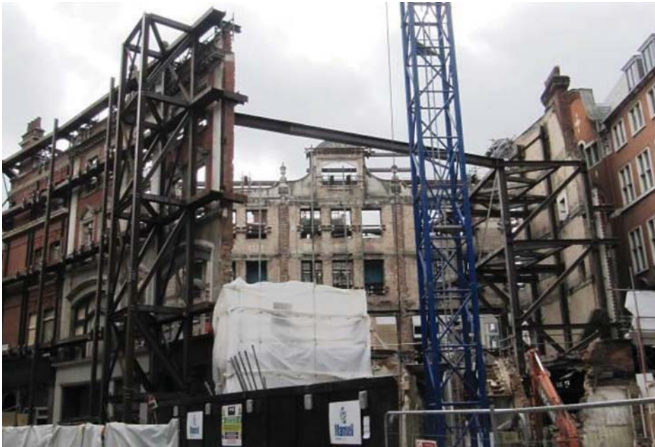
Rys. 1. Realizacja modernizacji budynku w Londynie z zachowaniem elewacji (fot. autor)
