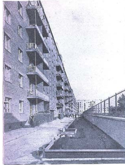
BUDYNEK DLA OFICERÓW PRZY UL. KOSZYKOWEJ, RÓG TOPOŁOŃSKIEJ W WARSZAWIE, WIDOK OD PODWÓRZA Str. 40
