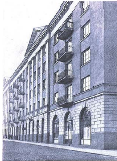
BUDYNEK DLA OFICERÓW W WILNIE PRZY UL. WILSKIEJI Str. 27
