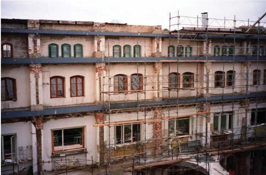
Rys. 11. Usztywnienie ściany wschodniej podłużnicami i żelbetowym stropem (fot. autor)
