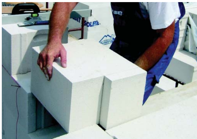
Fot. 2. Bloczki można łatwo dociąć i dopasować do każdego kształtu
