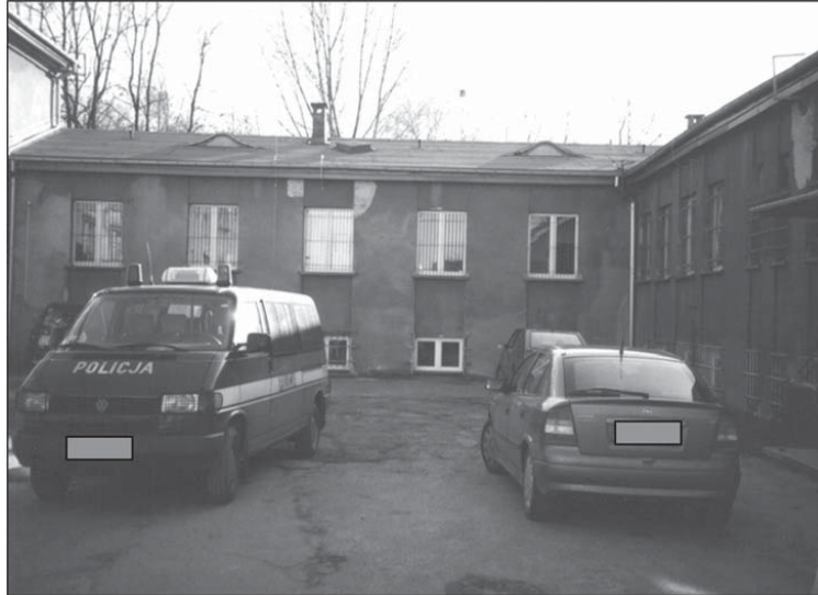
Rys. 3. Budynek w części przeznaczony do nadbudowy
