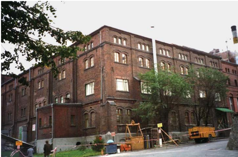
Rys. 9. Widok modernizowanego budynku stodołni (fot. autor)
