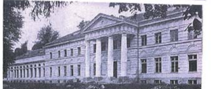
Opatów. Pałac. Zniszczenia w czasie wojny. Rys. 3
