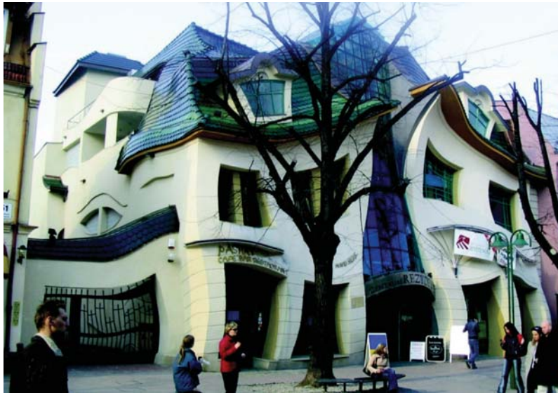
Fot. 9. Krzywy Domek w Sopocie. Efekt końcowy fasady wykonanej z ABK. Żaden inny materiał nie spełniłby oczekiwań technicznych przy realizacji tego budynku [6] [7]
