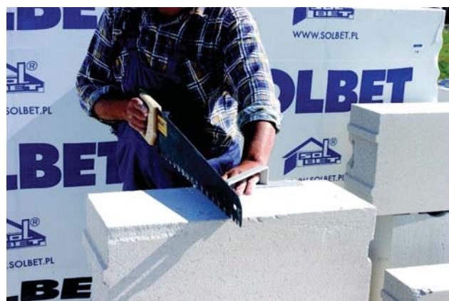
Fot. 1. Elementy z ABK bardzo łatwo się docina, to ułatwienie dla wykonawców
